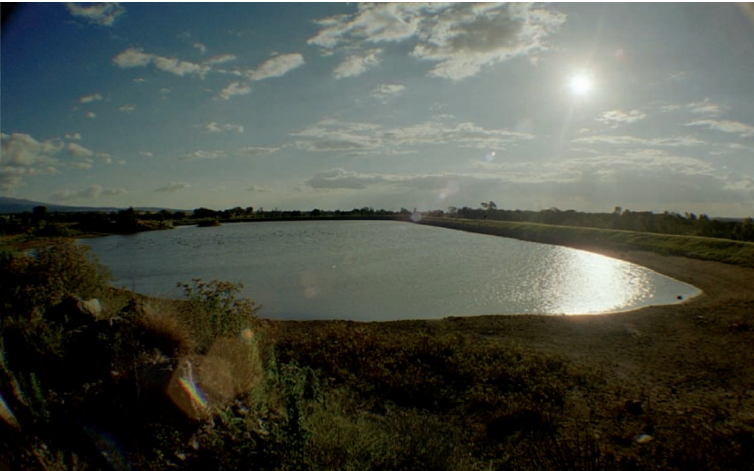
Abb. 5: Bewässerungssee. Solche Rückhaltebecken fassen die grossen Abflussmengen während den Regenzeiten und können helfen die Oberflächen-gewässer während der Trockenzeit zu entlasten. Bild: Roland Schuler
